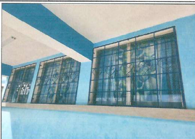
Foto 2: Mejoramiento e Instalación de 9 ventanas de PVC en aula de computación.
