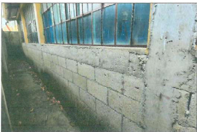
Foto 3: Mejoramiento de Pared trasera de aulas 1 y 2
