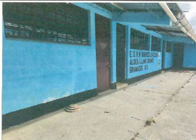
Foto 1: Mejoramiento e instalación de piso en corredores y aula de computación.
